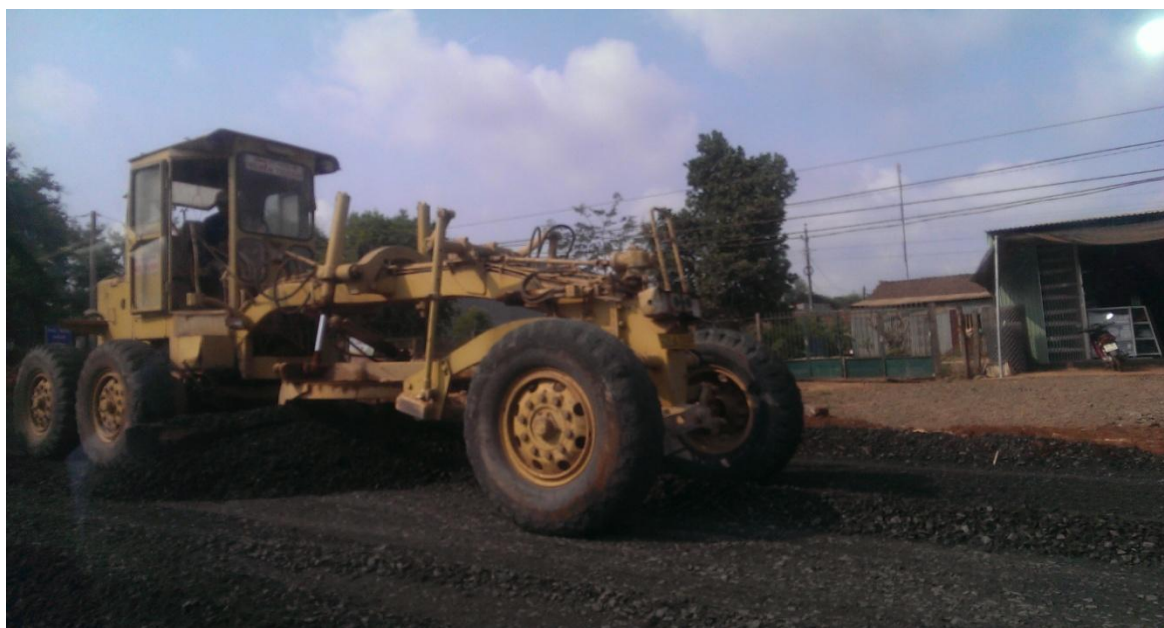
DLG đang gấp rút triển khai QL 14. Toàn bộ đá làm đường đều do các mỏ đá của DLG cung cấp
